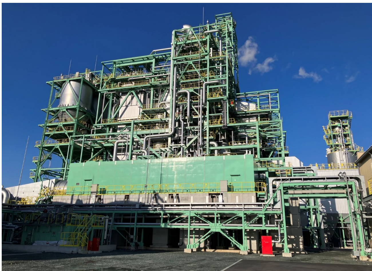
(本発電所外観)
