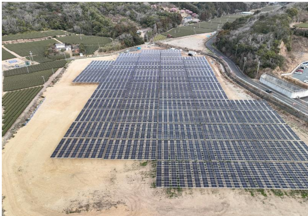
【本発電所の現況写真（※2023 年 3 月時点）】
