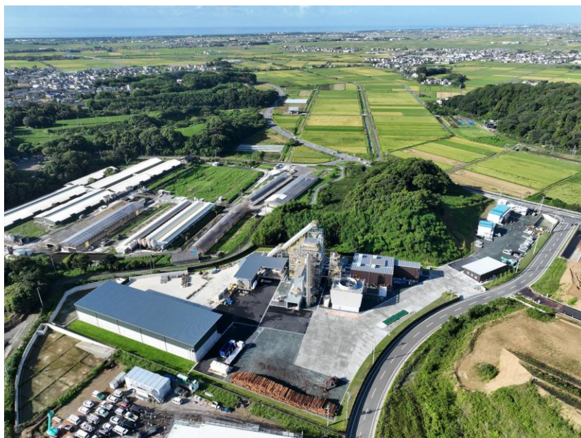
(本事業会社が所有する発電所の全景)
