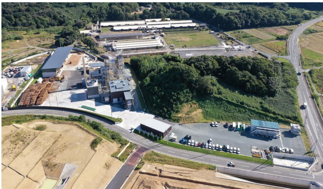
(本発電所の全景)
