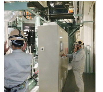
ガスエンジン試運転
