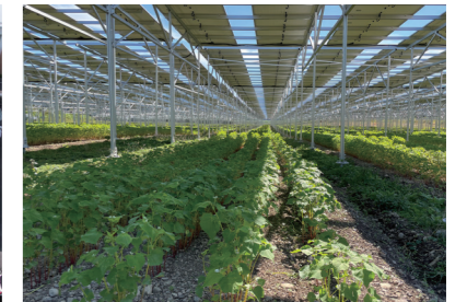
袋井市岡崎営農型太陽光発電所 (2023年5月開所)
