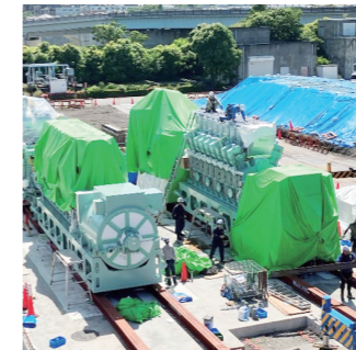
ガスエンジン設置工事①
