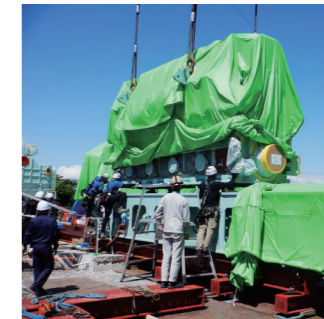
ガスエンジン設置工事②
