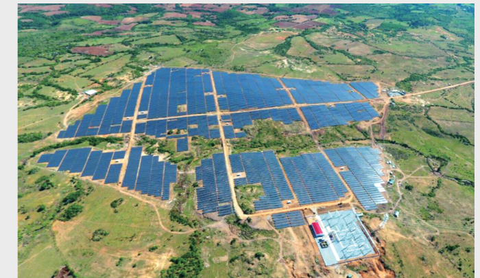
Myson発電所外観
