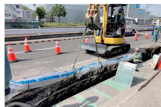
上：社内安全パトロール 下：水道本管の入替
